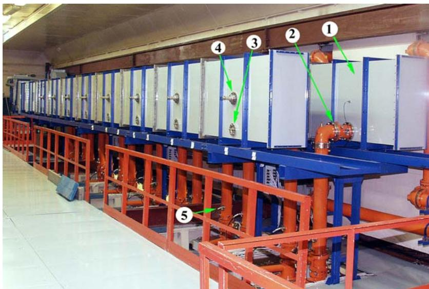
Рис. 6. Делители мощности на 8 резонаторов: 1 – волновод; 2 – коаксиальная линия к резонатору; 3 – механизм перемещения стержня КВП; 4 – механизм перемещения плунжера компенсации индуктивности КВП; 5 – петля измерения тока возбуждения резонатора
